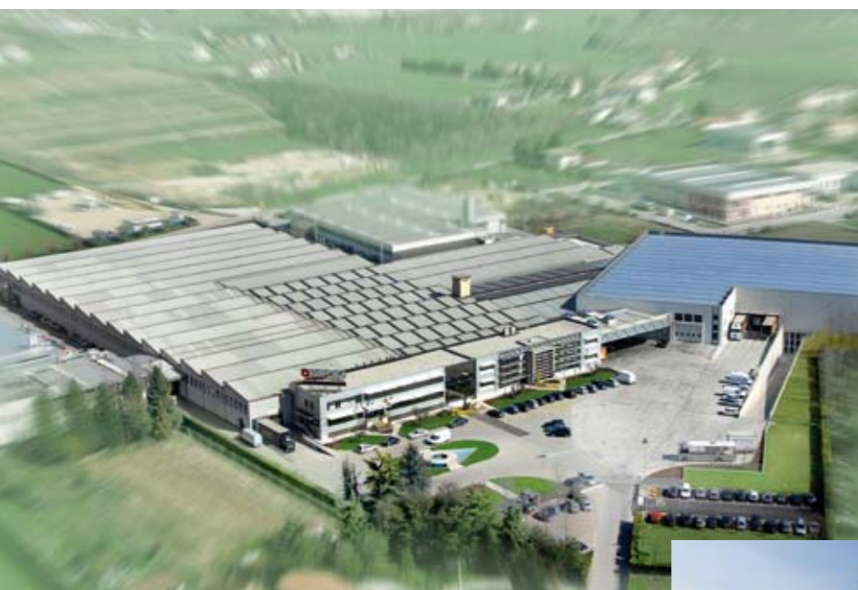
Stabilimento La Nordica Montecchio Precalcino
